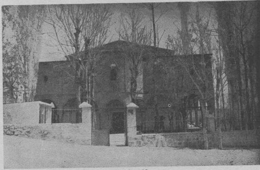
Resim 12 Fertek, Batı Cephe.
